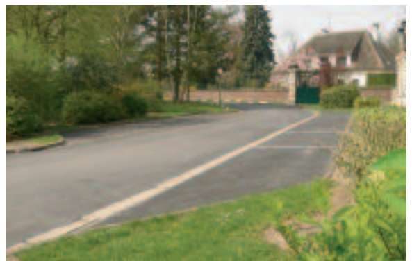
Aménagement de voirie, boulevard de la Liberté à Ham
